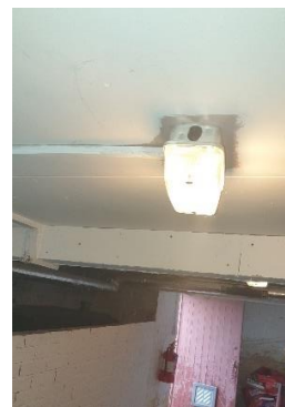
Bulkhead Luminaire
